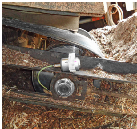
Die Y-Spannlageeinheit eines Förderbandes wird kontinuierlich mit Fett versorgt.
