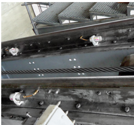
Mehrere Schmierstoffspender sind auf einem Seilsattel montiert. Dank der Montage einer Magnethalteschelle werden aufwändige Installationen umgangen.
