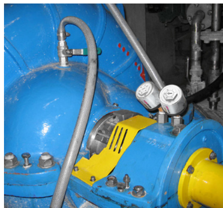
Deux simalube 30ml lubrifient le palier d'une pompe.
