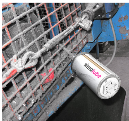
L'installation de simalube à l'extérieur de l'entrepôt garantit la propreté du point de lubrification.
